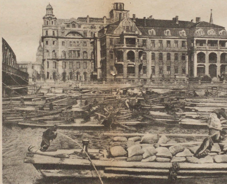
Консульство СССР в Шанхае (здание «Отель Астор») на набережной Вампу.
